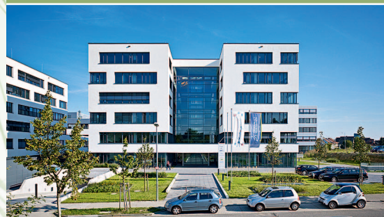
Die DGNB zertifizierte das Bürogebäude STEP 8.2, Stuttgart-Vaihingen, für seine innovative und nachhaltige Gebäudeperformance mit dem Gütesiegel in Gold.
