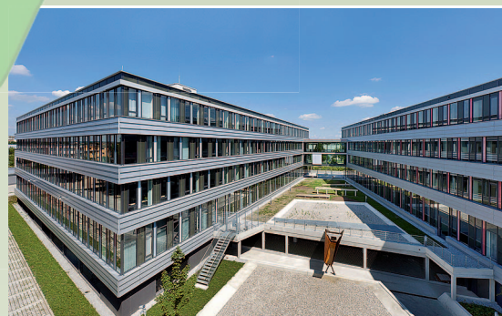
Das Verwaltungsgebäude AREVA Move II, Erlangen, wurde für seinen Nutzerkomfort sowie die ökologische und ökonomische Qualität mit dem DGNB-Zertifikat in Gold ausgezeichnet.
