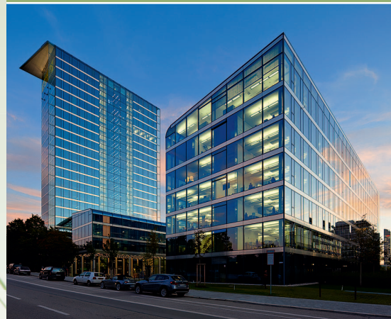
Für seine ökologische, ökonomische und soziokulturelle funktionale Qualität erhielt das Büro- und Verwaltungsgebäude Bürogebäude THE m.pire, München, ein DGNB-Zertifikat in Gold.
