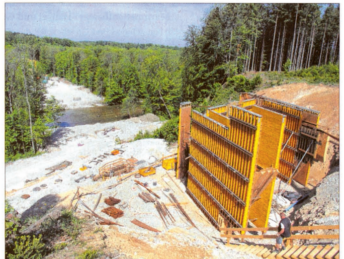
Die Schneise für die 385 Meter lange Brücke über das Trauntal: Derzeit werden die Fundamente für die Stützen erstellt.
