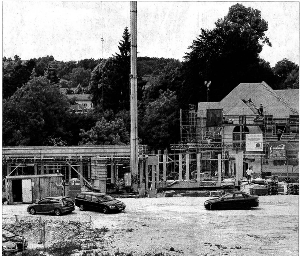
Bei der Sanierung der Ebersbacher Kauffmann-Villa und dem Anbau für die Musikschule läuft bislang alles nach Plan. Das vom Investor beauftragte Bauunternehmen wird jedoch erst im Juli loslegen. Foto: Dirk Hülser
